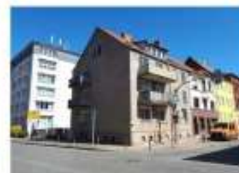
Das Eckhaus in der Havelberger Straße 83 wird in diesem Jahr grundlegend saniert. Es steht seit 20 Jahren leer.
