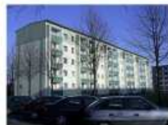
Der Block am Kietz bekommt 2022 neue Elektro- und Sanitärstränge sowie eine komplett neue Heizungsverteilung.
